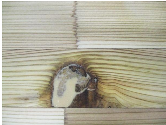
写真 2 フシ処理の例（エポキシ樹脂）
